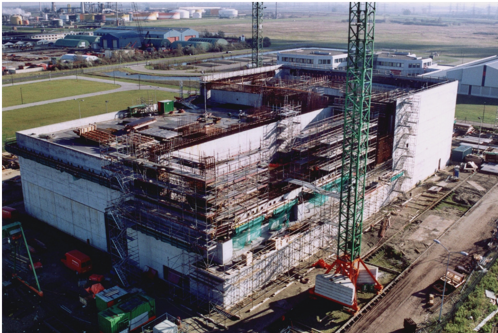
Figuur 3.4 Het HABOG in aanbouw op het COVRA-terrein (situatie 2000)
